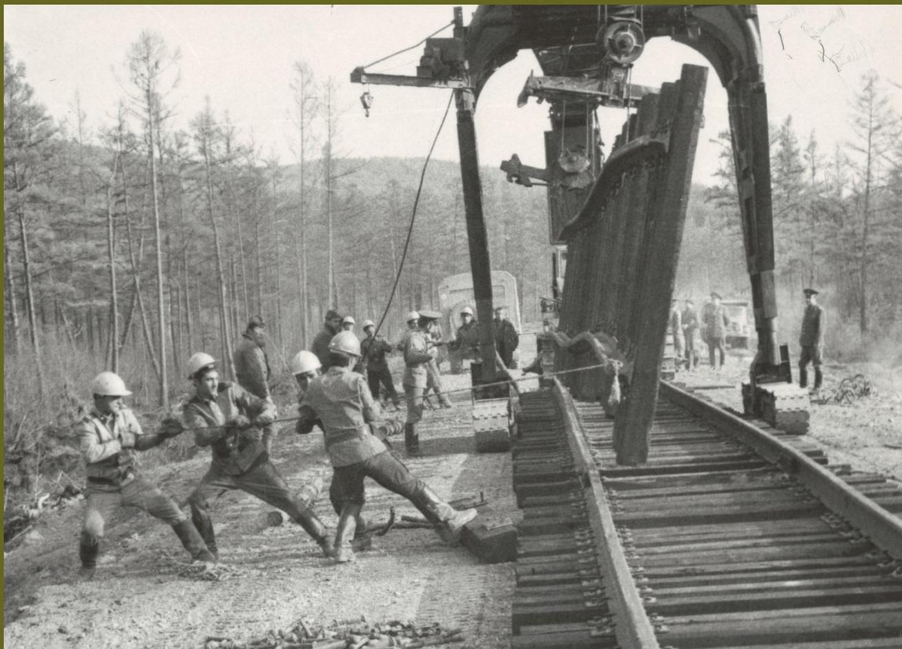
**Укладка пути тракторным путеукладчиком ПБ-3М.
